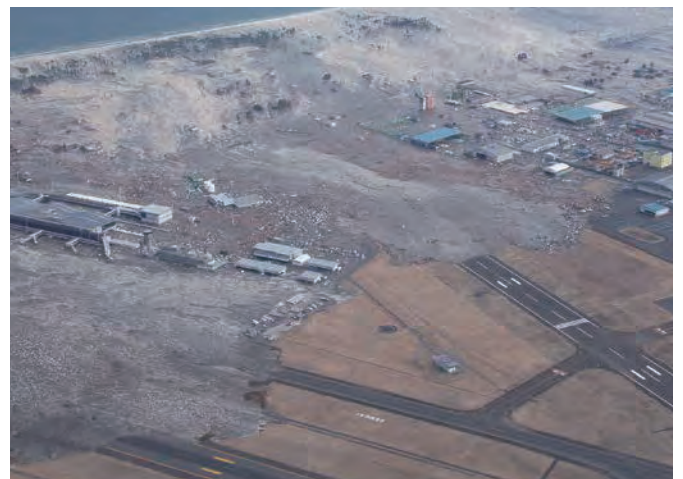
巨大津波にのみこまれていく仙台空港
