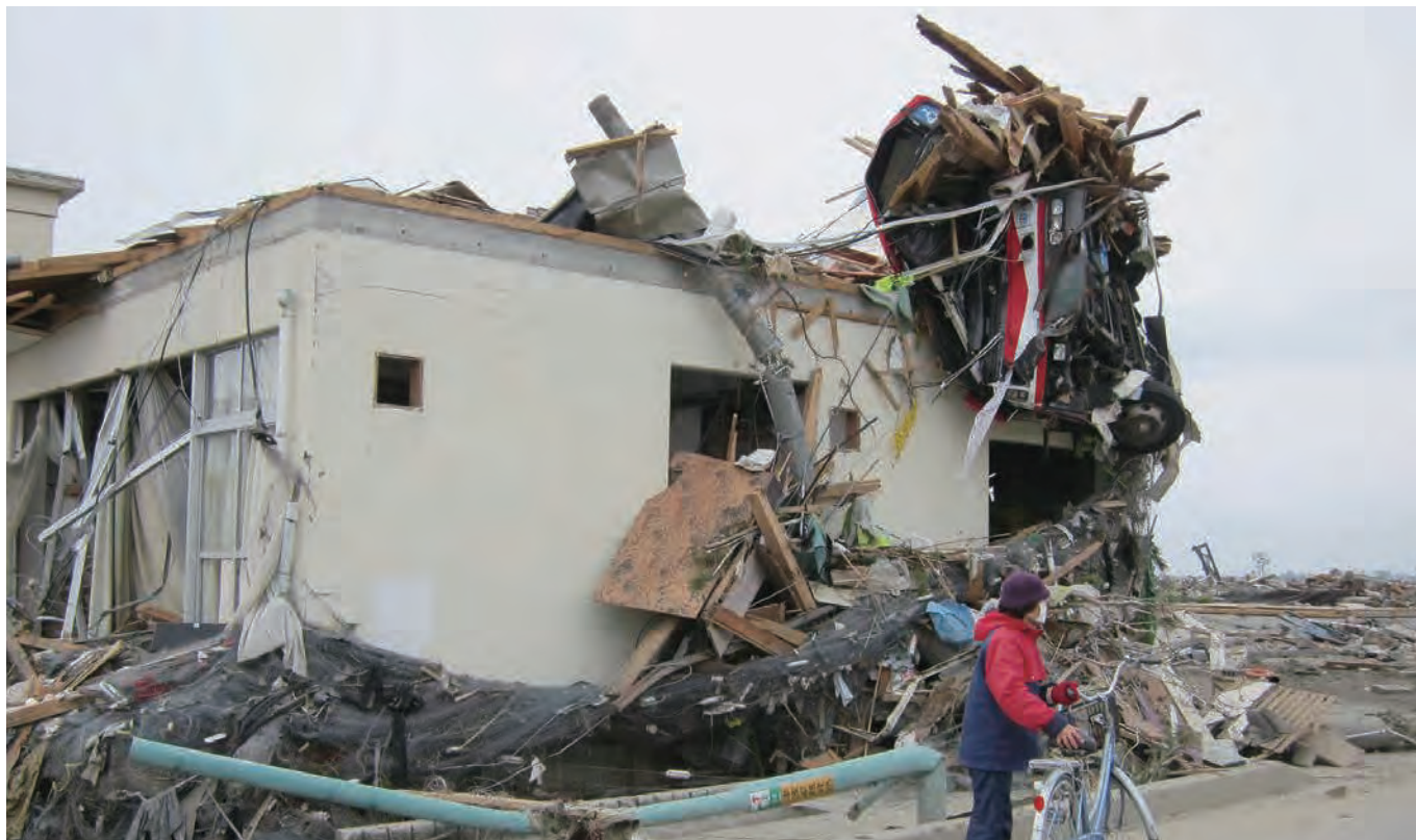
関上6丁目 日和山団地集会所 上に乗っているのは、原型を留めていないカシバスである。
