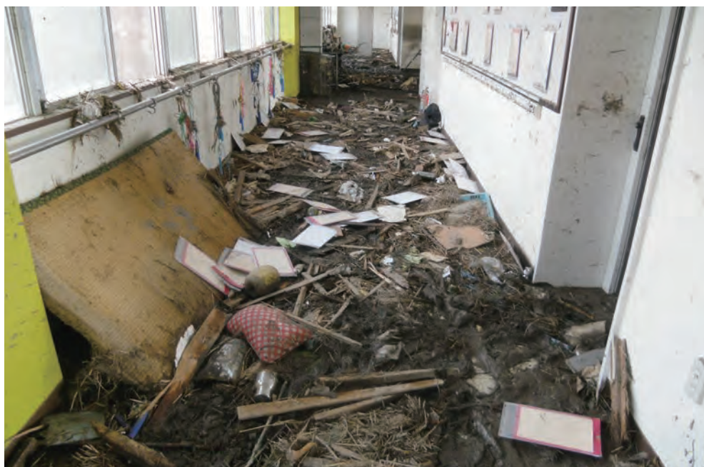
関上小学校1階廊下
