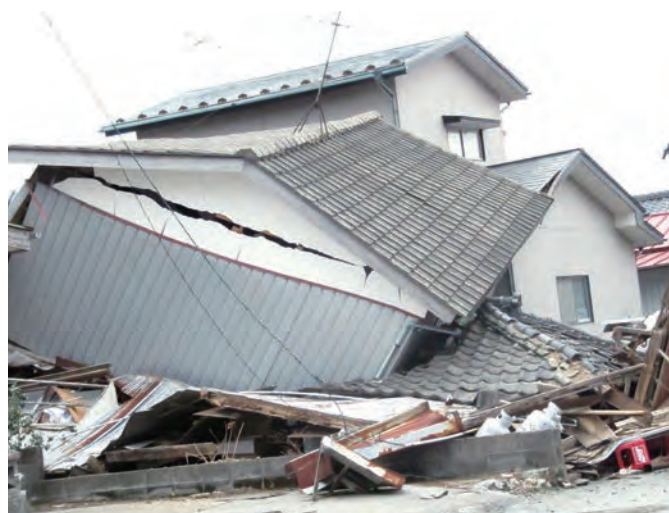
閉上の倒壊した家屋、その後津波が襲来した。
