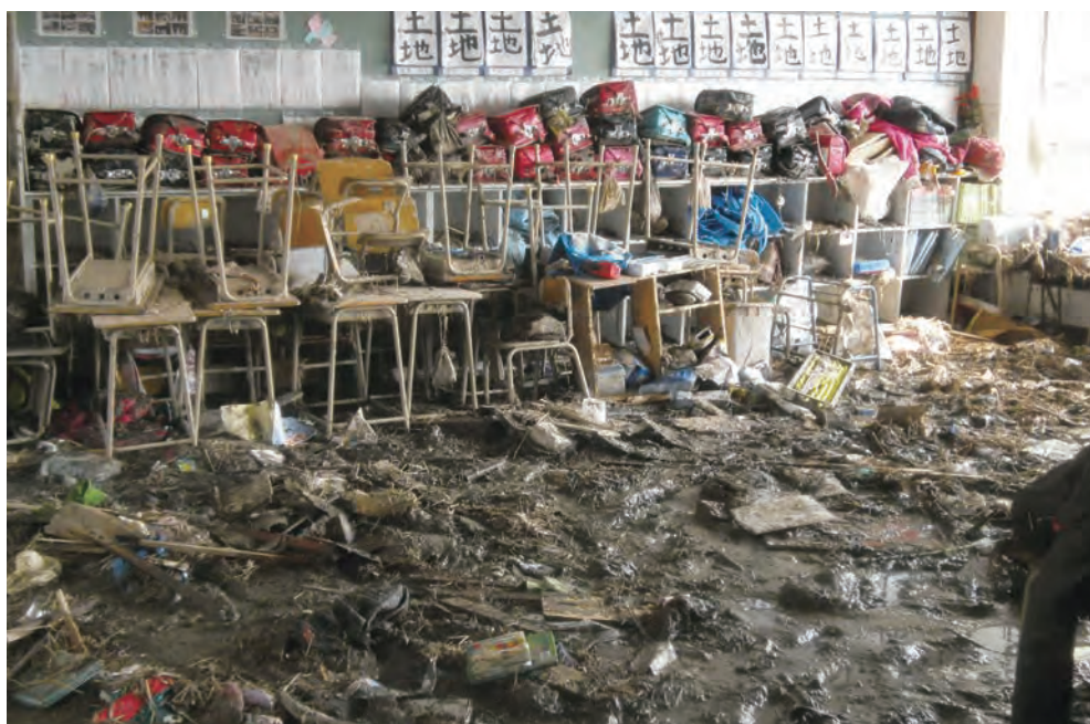
関上小学校1階教室内
