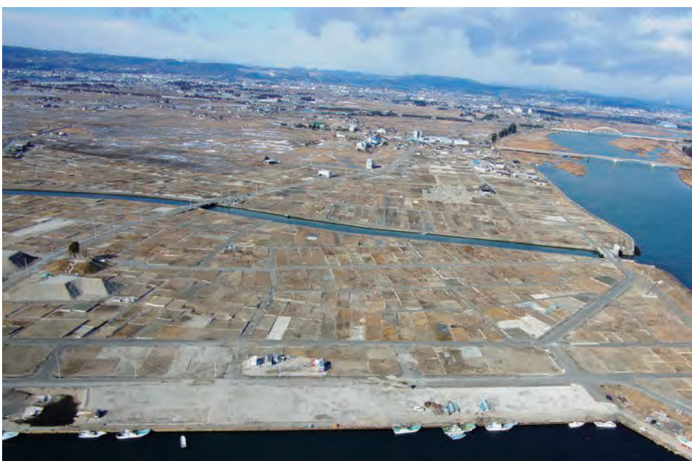
震災から10カ月後の関上地区沿岸部
