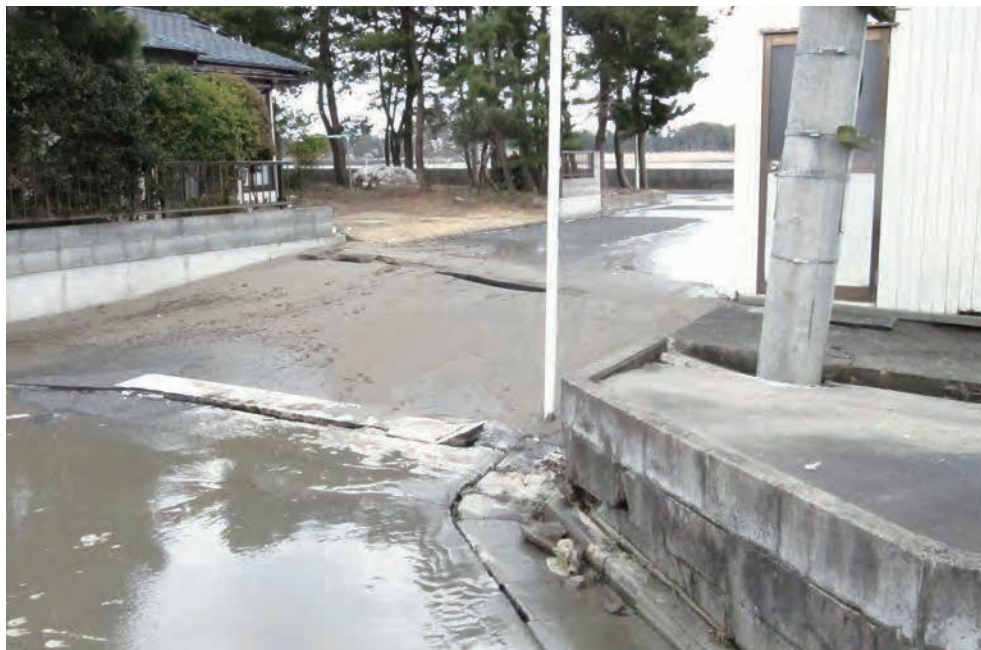
液状化現象により電柱が埋没、道路には砂と水が広がっている。
