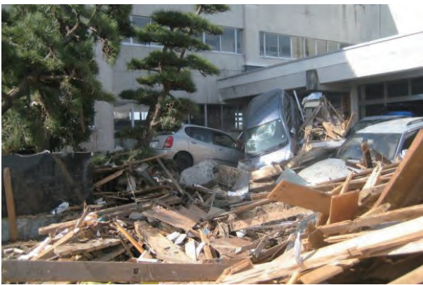
津波被害(関上中学校) 平成23年3月14日 八森伸
