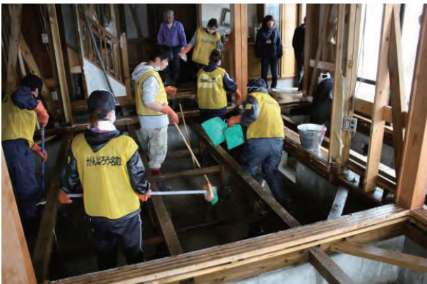
ボランティアによる泥出し作業 平成23年4月29日 名取市社会福祉協議会
