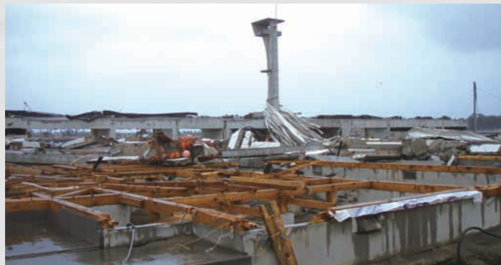
関上漁港魚市場 屋根の鉄板が津波により剥がされ漁港塔に巻き付いている。
