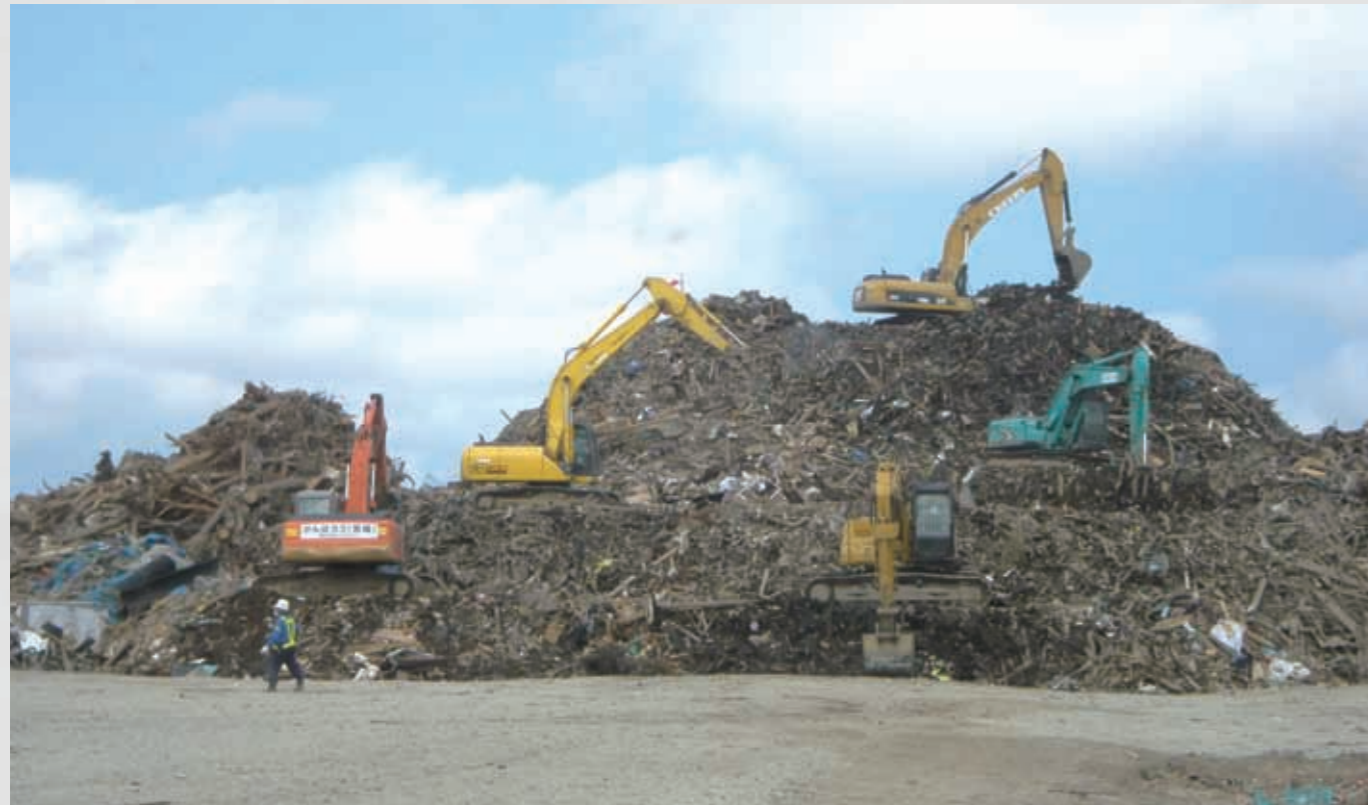
積み上げられた膨大な量のがれき
