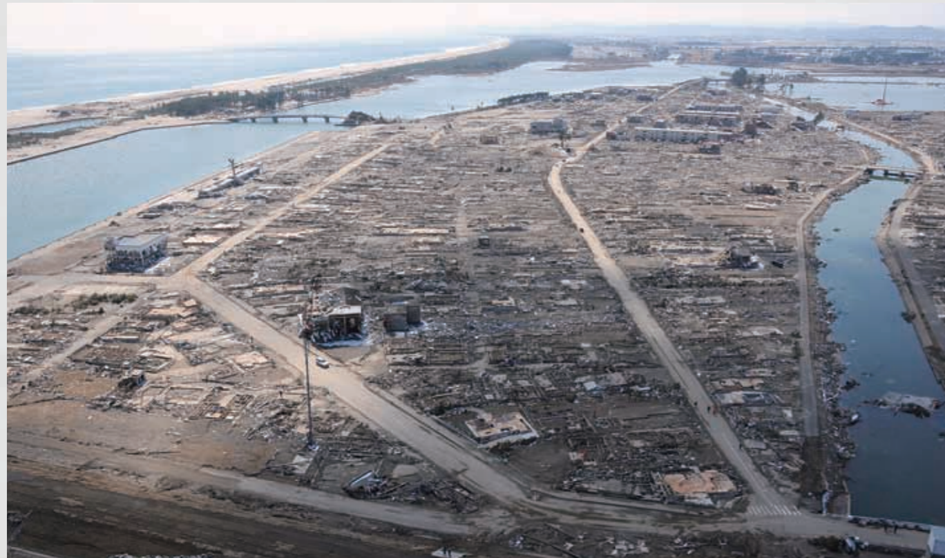
関上地区沿岸部
