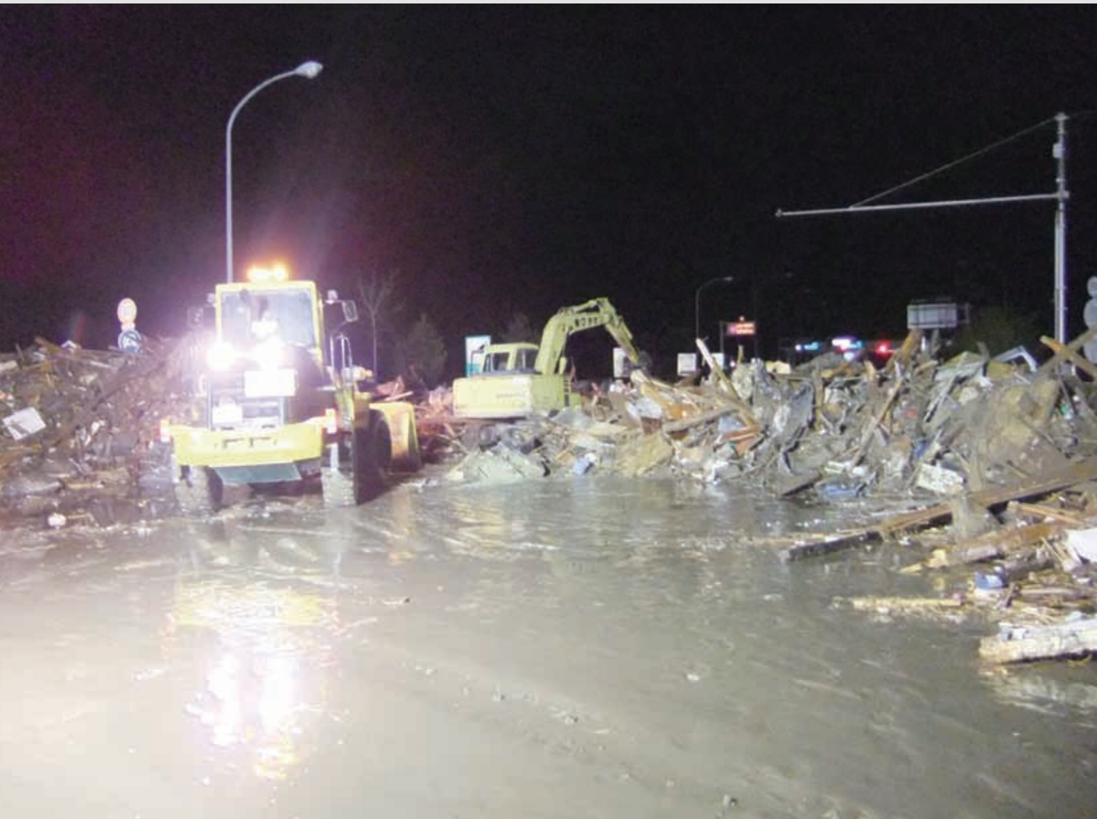
夜を徹して行われた懸命な道路啓開作業 「閉上街道」の仙台東部道路名取インターチェンジ付近。 156 平成23年3月12日 名取市
