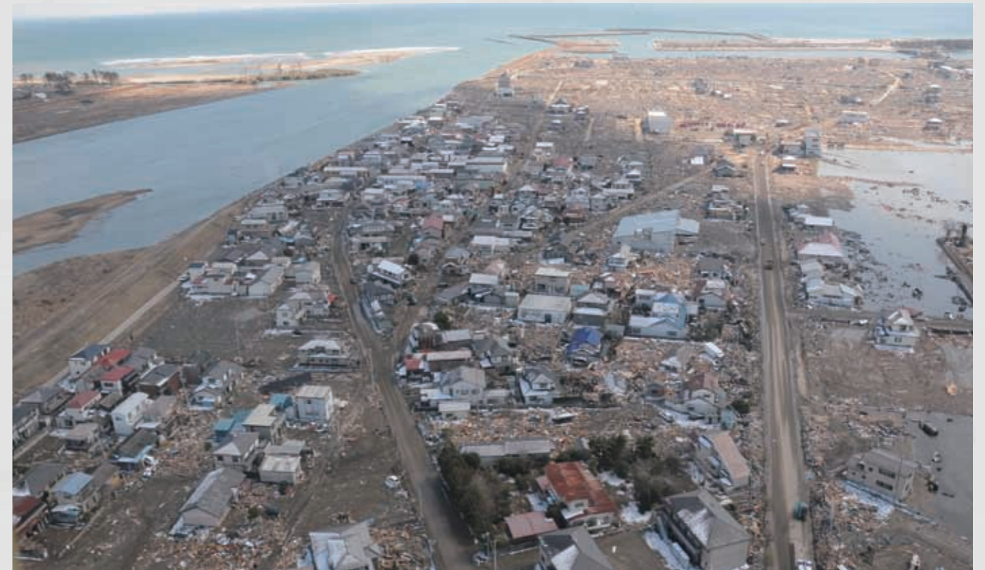
関上地区沿岸部
