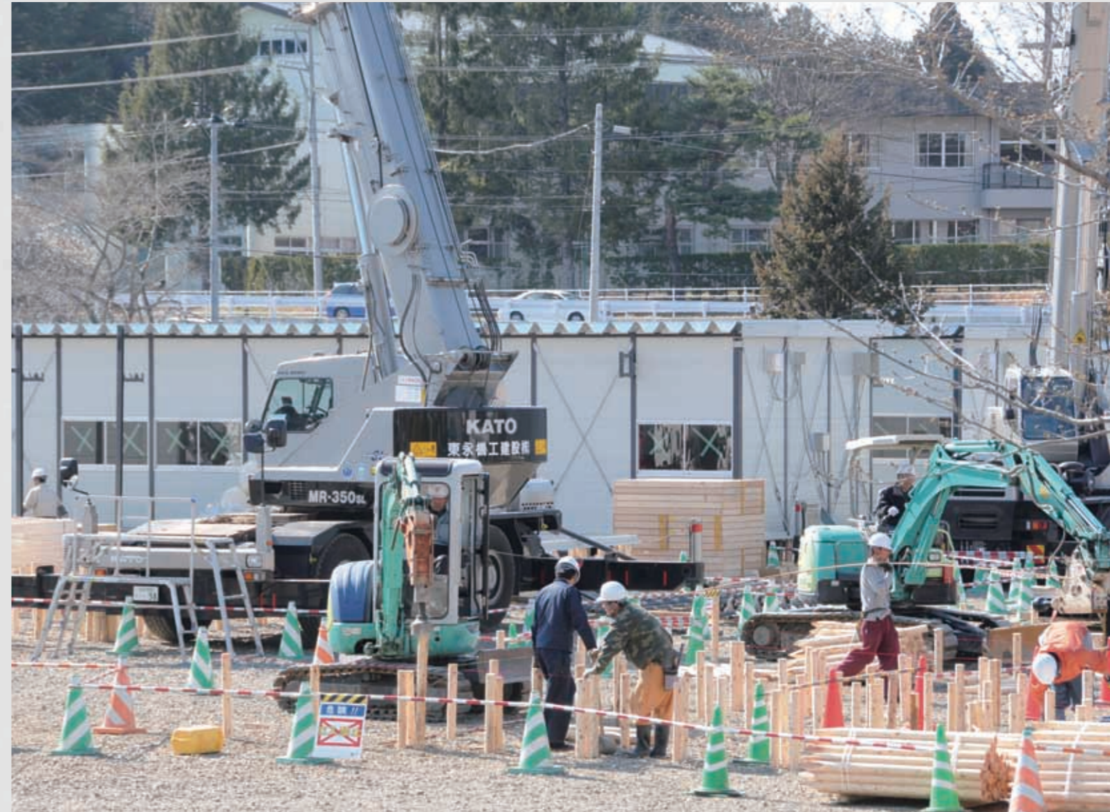
応急仮設住宅の建設
