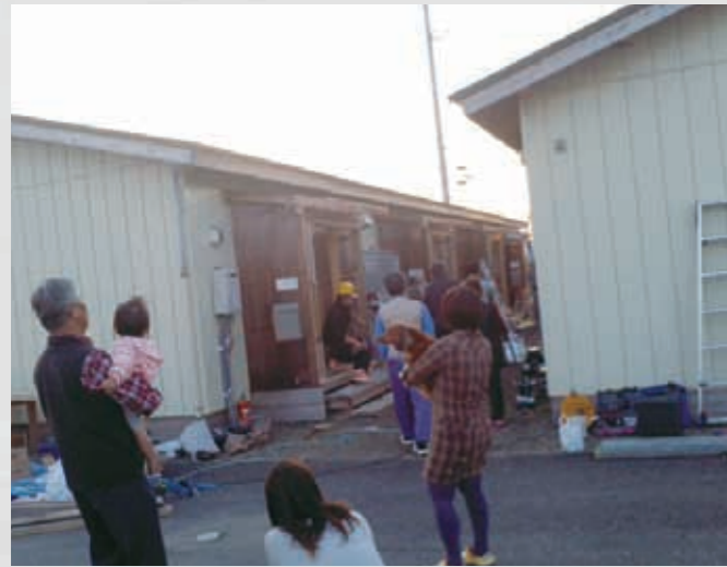
風除室の取り付け工事 ㉚ 平成23年11月1日 名取市
