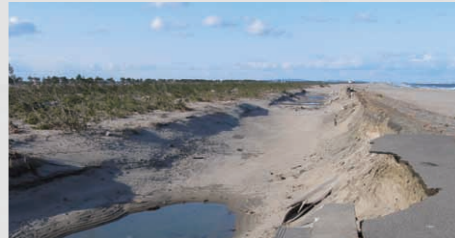
なぎ倒され流出した海岸の防潮林とえぐられた防潮堤 362 平成23年3月27日 名取市消防本部
