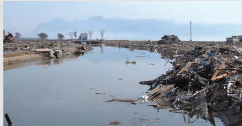
市登録文化財の開運橋は、完全に崩落した。 358 平成23年3月13日 名取市消防本部
