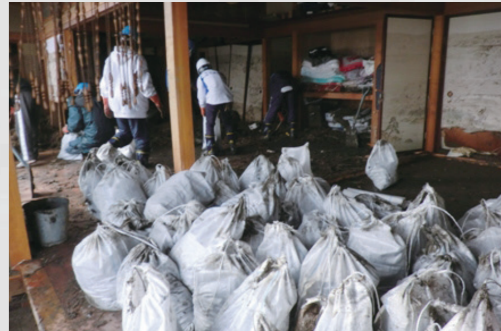
ボランティアによる泥出し作業 震災直後から多くのボランティアの皆さんに様々な面で助けをいただいている。
