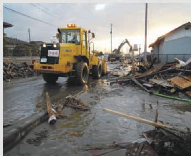
内陸部から閉上へ向う「閉上街道」 154 平成23年3月12日 名取市
