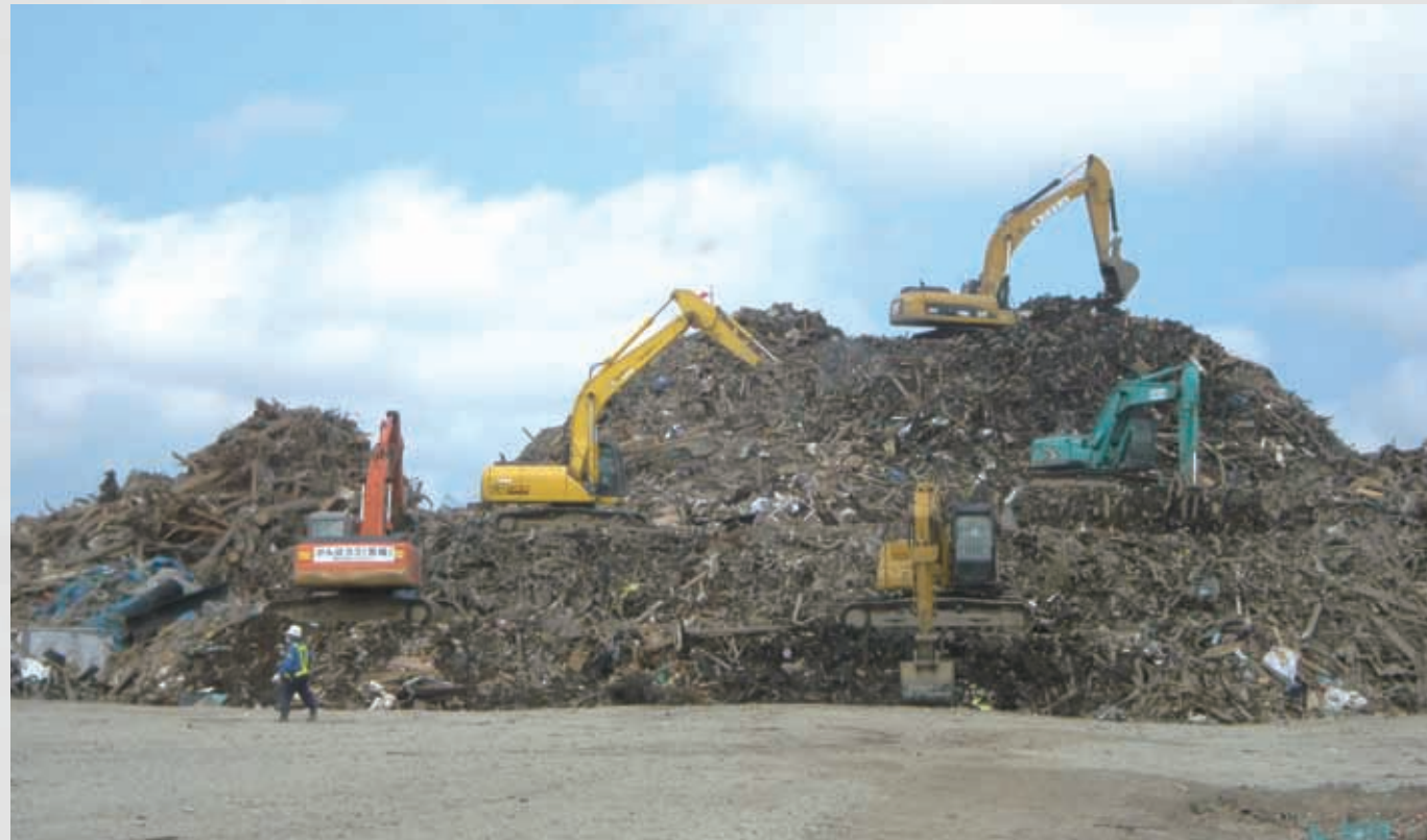
積み上げられた膨大な量のがれき
