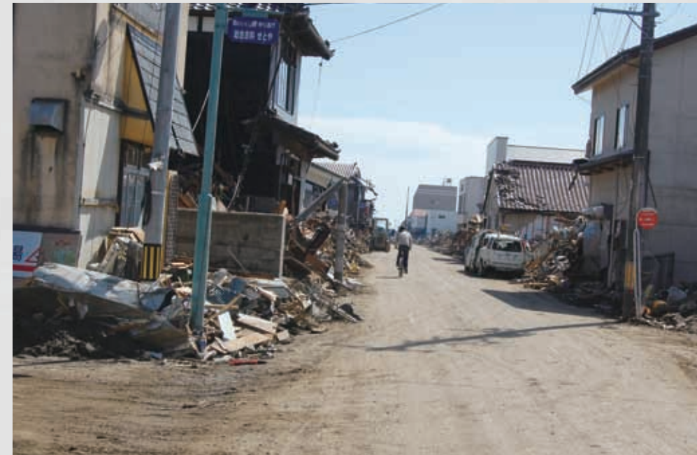
震災1週間後の閉上 懸命な道路啓開とがれきの撤去作業により、場所によっては、かなり片付いている。 162 平成23年3月19日 個人
