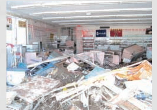
左の写真の店舗内部 ⑩④ 平成23年4月6日 橋浦精麦倉庫(株)
