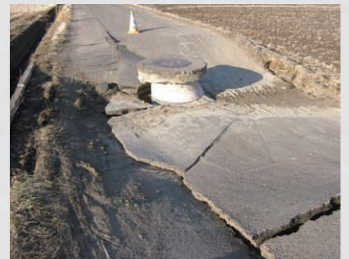
飯野坂 道路や歩道の部分的な沈下や橋の連結部の段差など、地震動により市内各所に被害が発生した。
