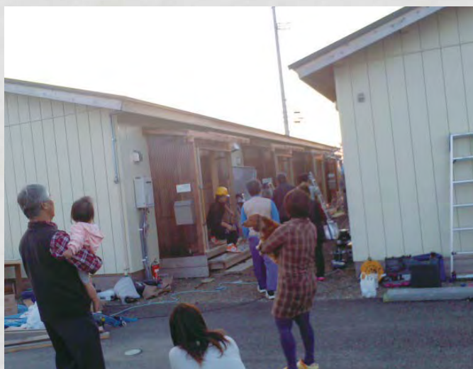
風除室の取り付け工事 290 平成23年11月1日 名取市
