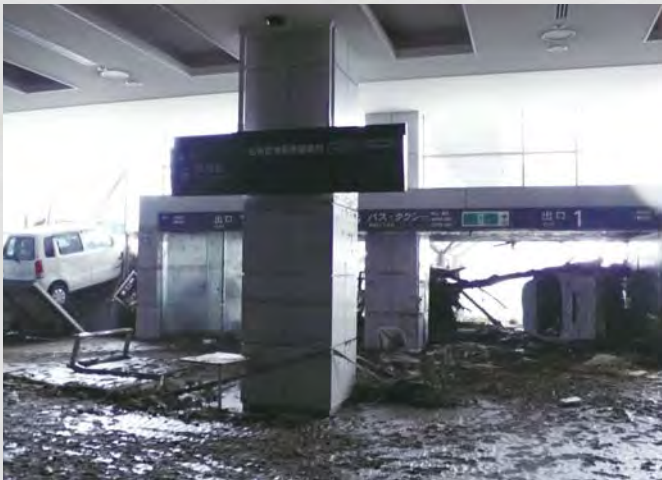
仙台空港ターミナルビル1階内部 ⑬2 平成23年3月16日 仙台空港ビル(株)
