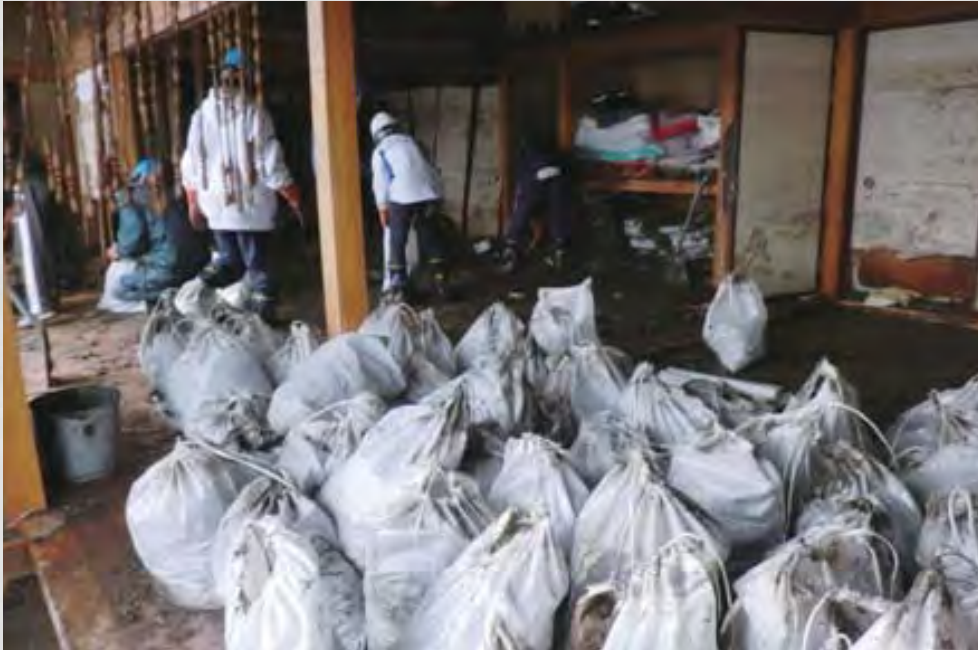
ボランティアによる泥出し作業
