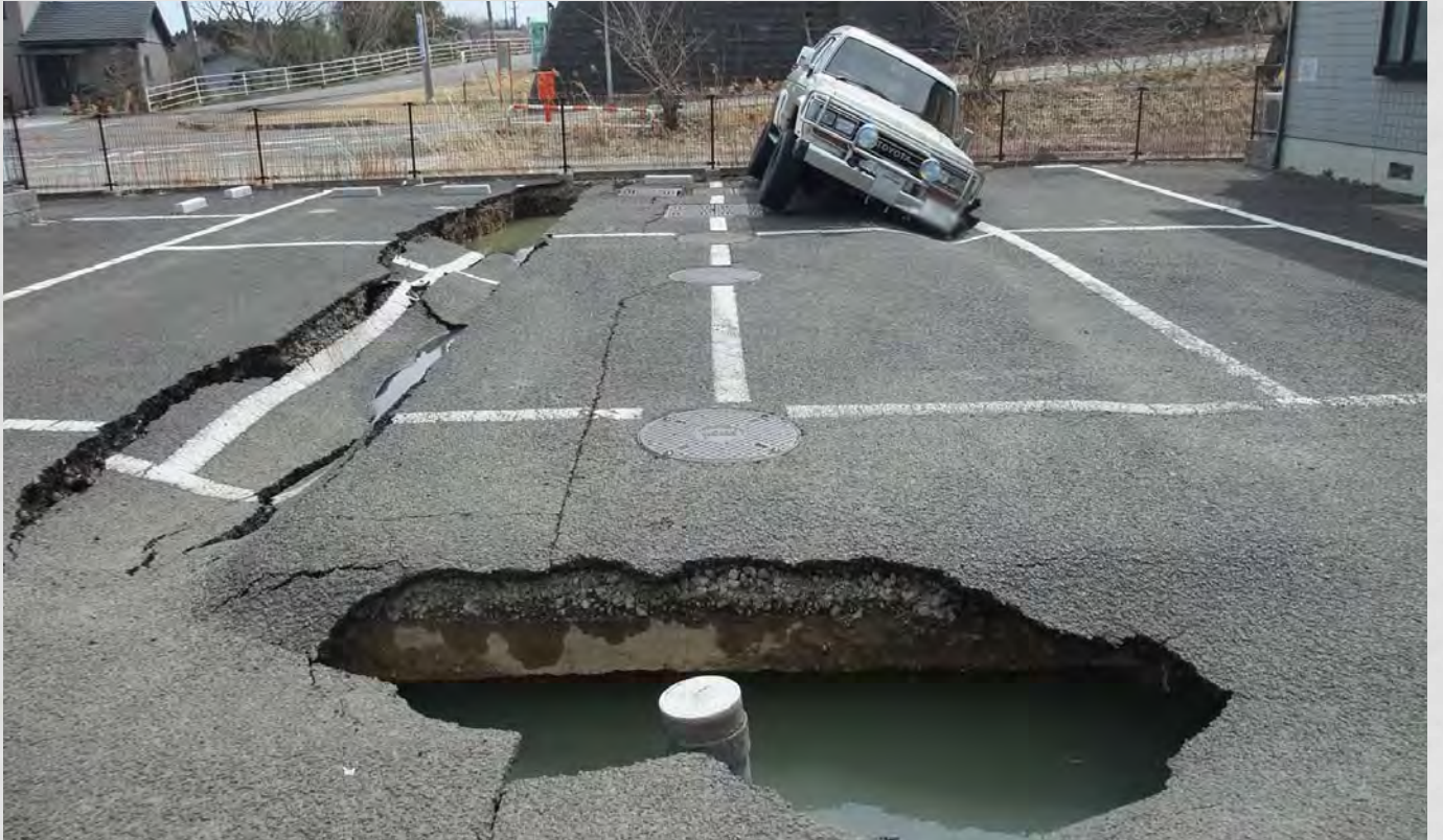
愛島塩手 表面のアスファルトを残し地盤沈下。
