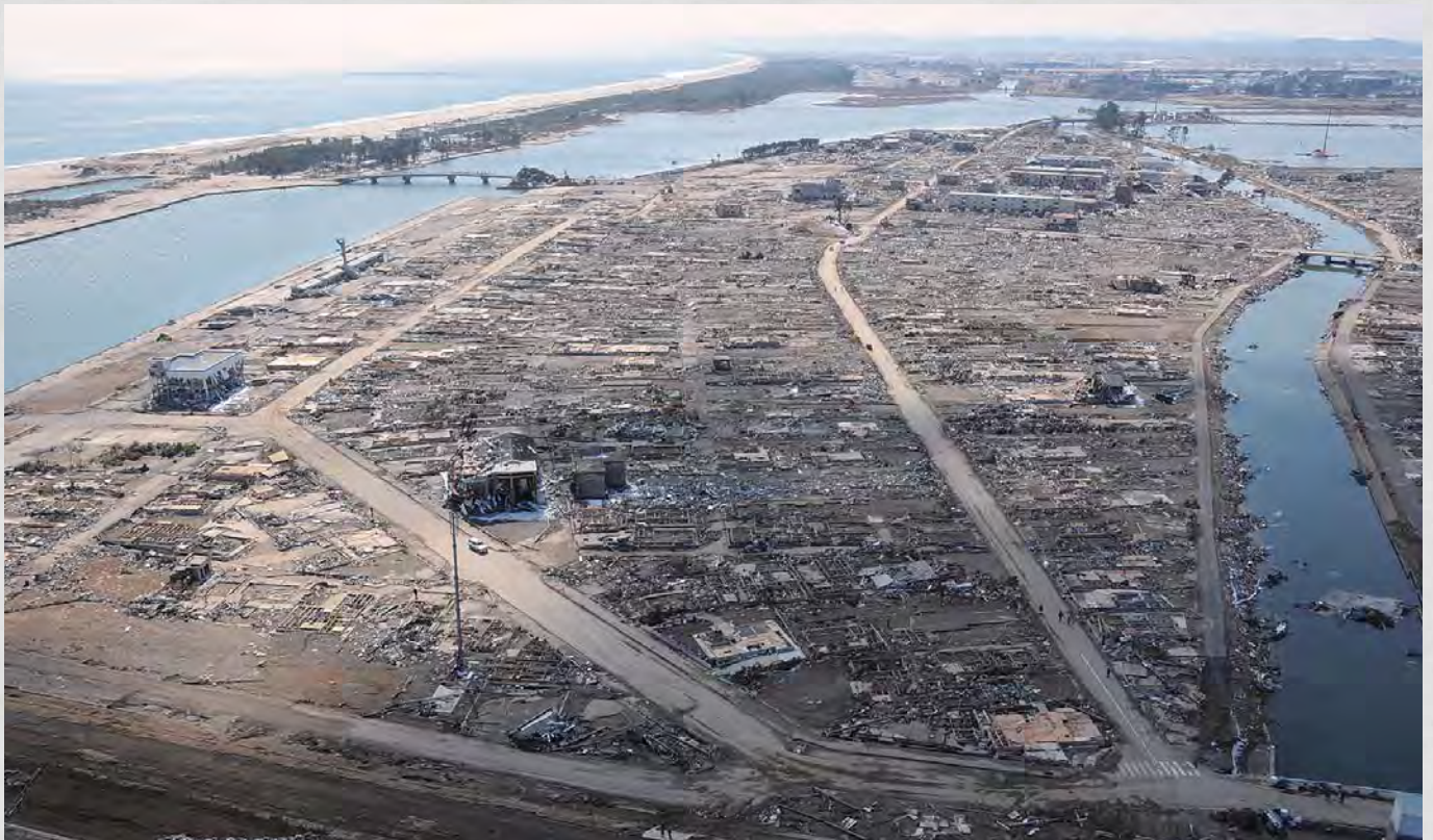
関上地区沿岸部
