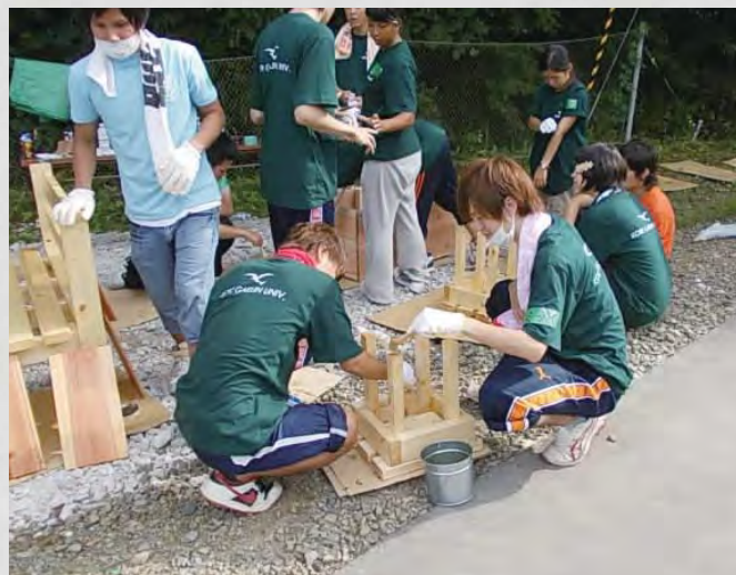
仮設住宅へのベンチの設置
