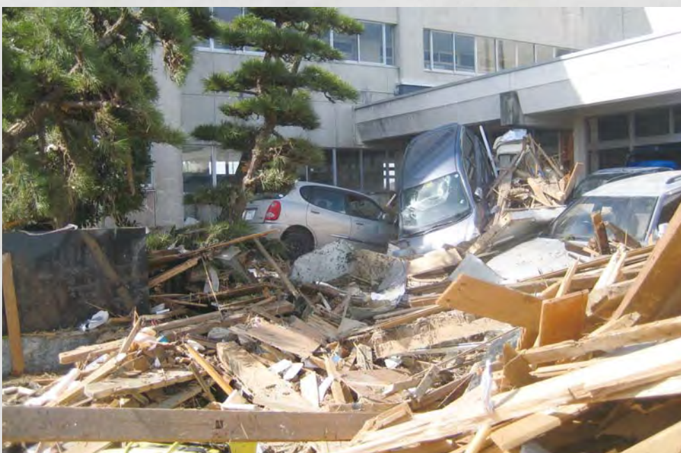
関上中学校昇降口付近
