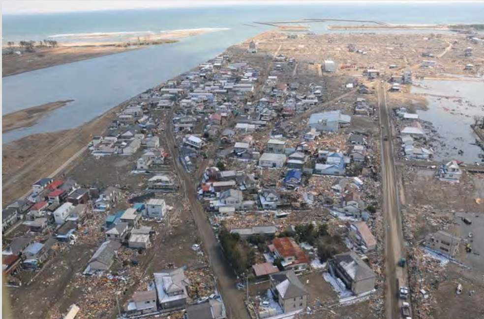
関上地区沿岸部
