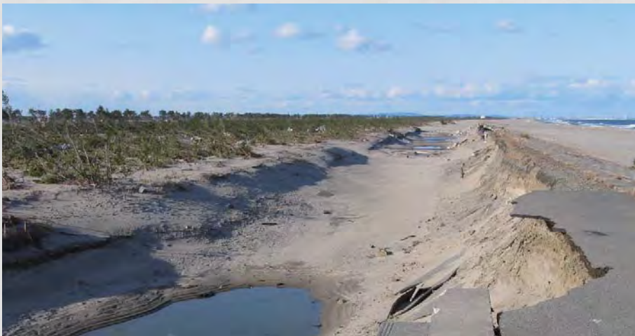
なぎ倒され流出した海岸の 防潮林とえぐられた防潮堤
